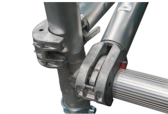
Fot. 19 Prawidłowe miejsce zamontowania stężeń.
